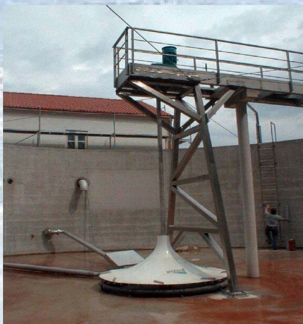
Фиг. 9: HYPERCLASSIC®-бъркалка, монтирана в буферен резервоар, който е инсталиран пред НОК ПСОВ на голяма текстилна фабрика за боядисване в Мароко като изравнител. Общото проектиране и техническото оборудване е дело от Биогест Интернационал ООД.
