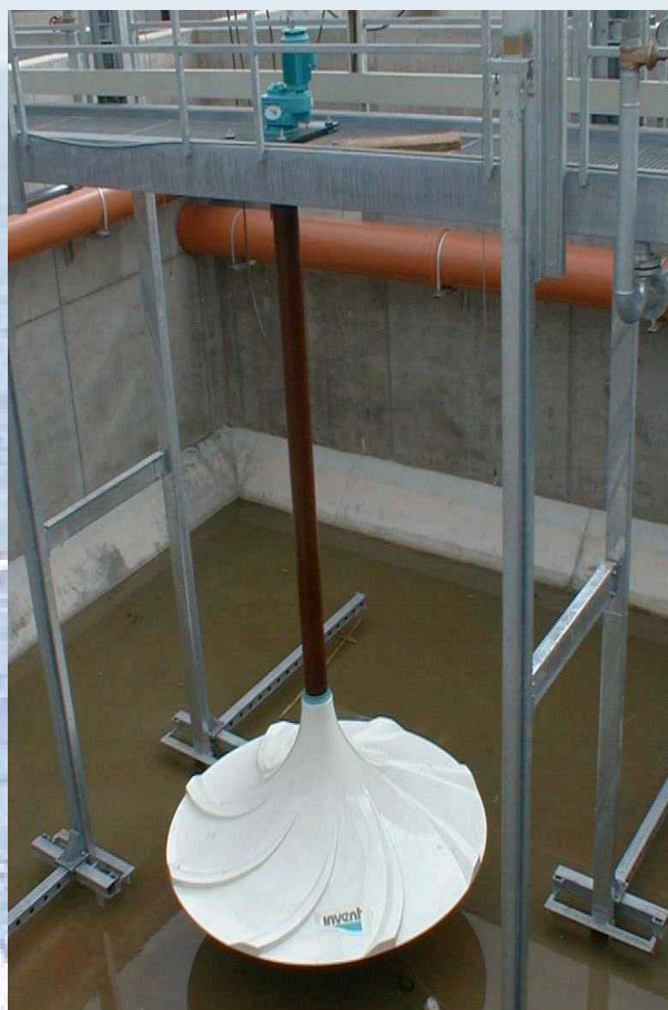
Фиг. 8: Монтаж на една HYPERCLASSIC®-бъркалка в биобасейн, който се експлоатира с прекъсване (нитрификация и денитрификация). При този проект се използват мембранни аератори. Ясно се виждат подготвените шлаухни модули зад бъркалката.
