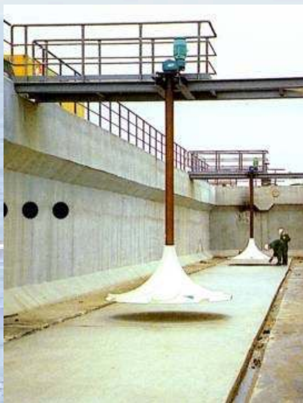
Фиг. 3 Две бъркалки HYPERCLASSIC® в басейн за денитрификация. Типичният дизайн и простият монтаж се виждат особено ясно.
