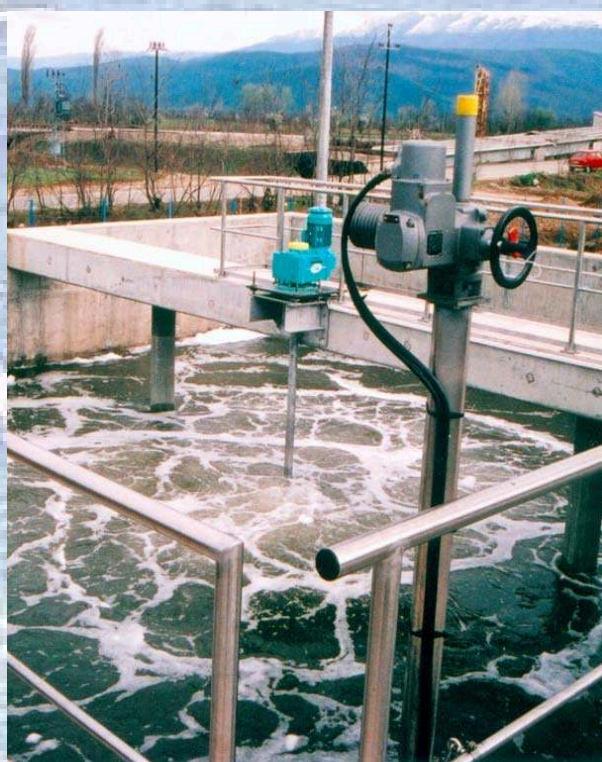
Фиг. 6: Една аерационна система HYPERCLASSIC® в SBR ПСОВ, която е пусната до ключ в SEE-университета в Тетово (Македония) от Биогест Интернационал ООД.
