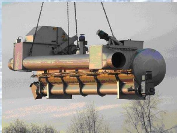
Компактно механично стъпало с „валов“ пясъкозадържател преди монтажа в подготвената сграда
