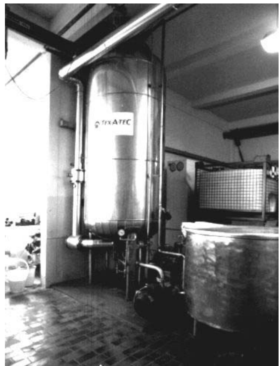
ORCAN ® -反应器处理纺织废水 (CSB-降解和除色度)
