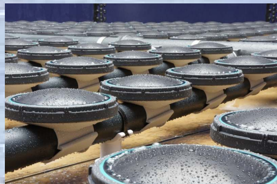
安装好的 iDISC® 膜式曝气系统
