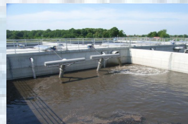
BSK®-Dekanter für die kroatische Kläranlage bei Koprivnica
