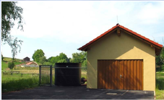
Zulaufpumpwerk mit Grobrechen und biologischem Luftfilter
