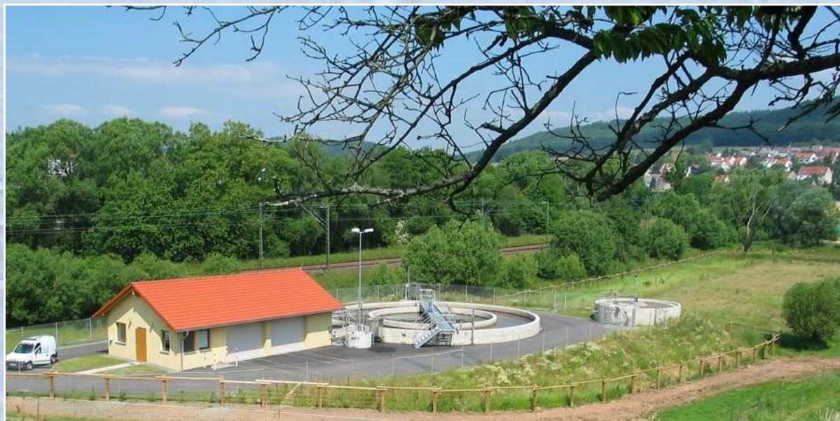
Ansicht der Kläranlage Niederlinxweiler mit Betriebsgebäude, Kombibecken und Schlammsilo
