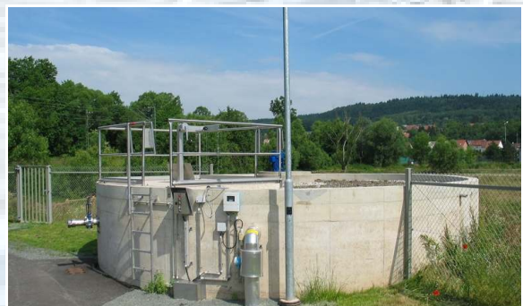
Abgedecktes Schlammsilo
