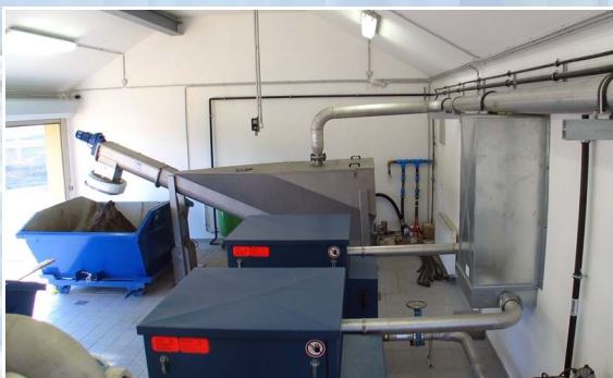
Gebläse für die Belebung (Vordergrund) und Sandklassierer
