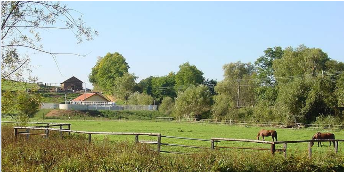
Homonische Einbindung der Kläranlage in die idyllische Landschaft von Niederlinxweiler
