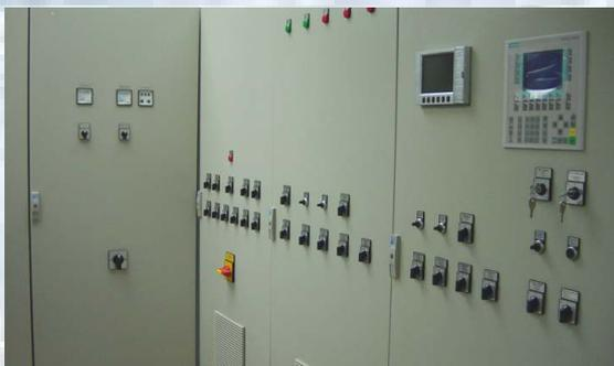
Die zentrale Steuerung aller technischen Komponenten erfolgt von der Schaltwarte aus. Mit Hilfe einer Fernan Kopplung ist auch eine direkte Kontrolle der Steuerungsvorgänge und eventueller Betriebsstörungen von der Biogest-Zentrale aus möglich.
