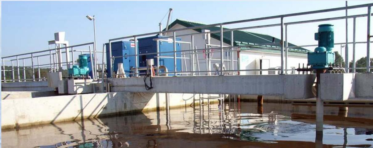
Blick auf die zentrale Anlagenplattform mit den beiden Drehkolbengebläsen
