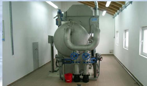
Kompakte Vorklärstation mit Feinsieb sowie belüftetem Sand- und Fettfang
