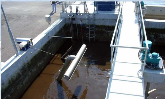
Der Abzug des Klarwassers erfolgt mit Hilfe der speziell entwickelten BSK®-Dekanter
