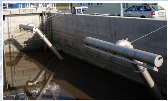
Zwei Klarwasserdekanter pro Reaktor
