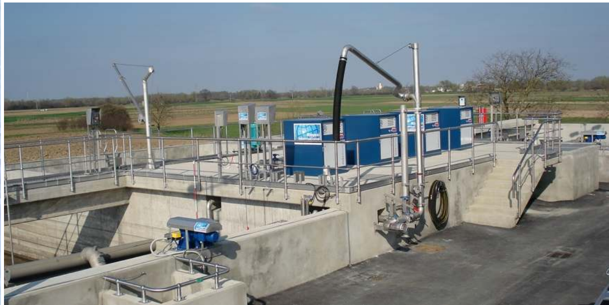
Ansicht der zweistraßigen SBR-Kläranlage VIRIJE von der Betriebsstraße aus
