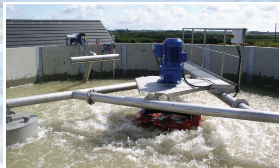
Oberflächenbelüfter (BSK®-Turbine) mit Schwimmsystem
