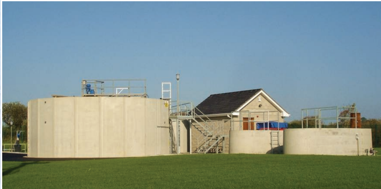
Gesamtansicht der biologischen Kläranlage der Gemeinde CARRIG ON BANNOW (Irland)
