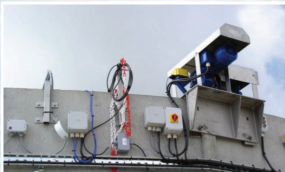
Elektrische Dekanterwinde mit Endschalter
