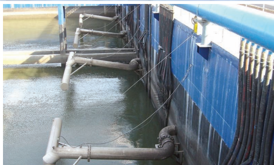
Montage der Dekanter in einem SBR-Reaktor
