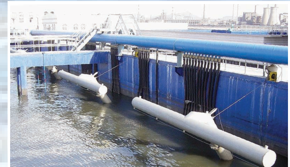
Dekanter in Wartestellung (obere Position)
