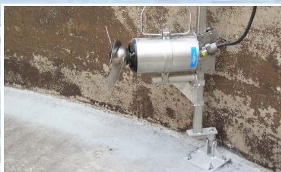
Horizontalrührwerk im biologischen Reaktor
