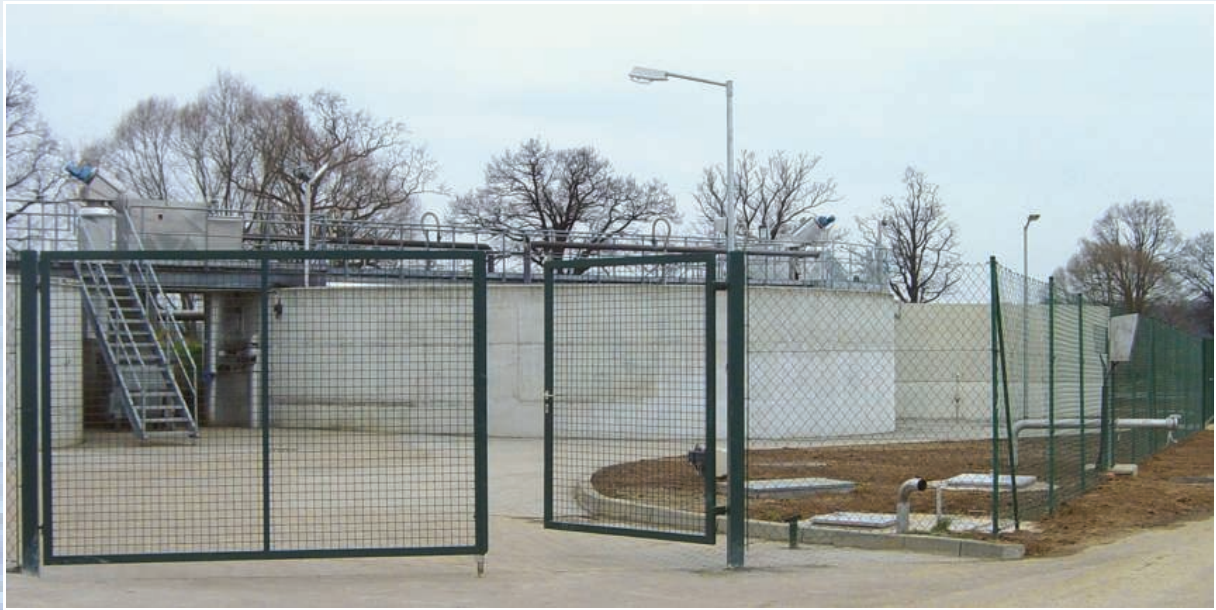
Blick vom Einfahrtstor auf die Kläranlage Guttau mit der Fäkalannahme (rechts im Bild)
