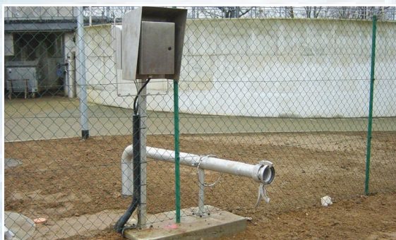
Fäkalannahmerohr mit Bedienkasten für 3 Entsorger
