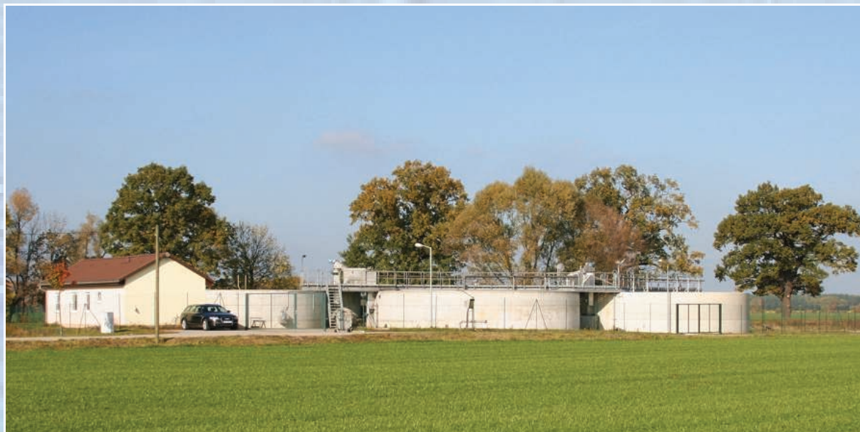
Ansicht der zweistraßigen SBR-Kläranlage GUTTAU
