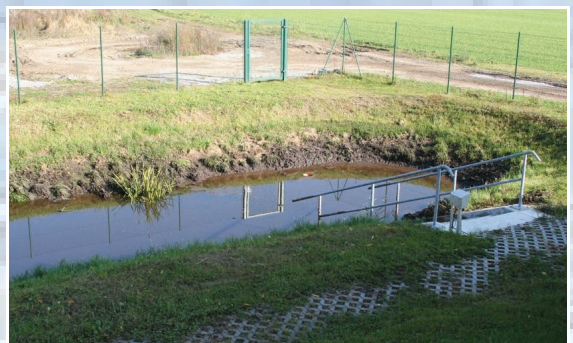
Pufferteich zur Vergleichmäßigung des Abflusses
