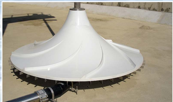
Detailansicht eines Rühr- und Begasungssystems
