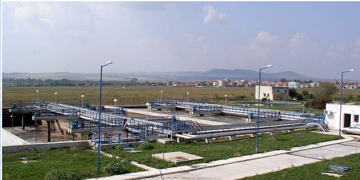
Ansicht der vierstraßigen SBR-Kläranlage des Ressorts SUNNY BEACH
