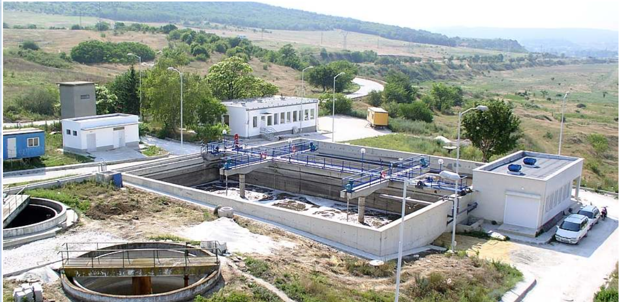
Ansicht der zweistraßigen SBR-Kläranlage der Gemeinde BELOSLAV
