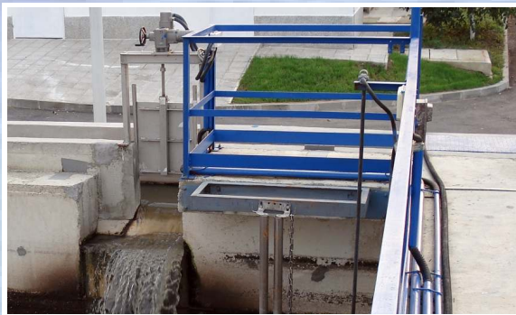
Automatisch gesteuerter Zulaufschieber für Reaktor 2
