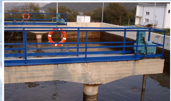
Bedienbrücke mit Antrieben für die Rührwerke
