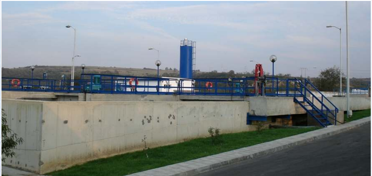
Blick von der Zufahrtsstraße auf die beiden SB-Reaktoren
