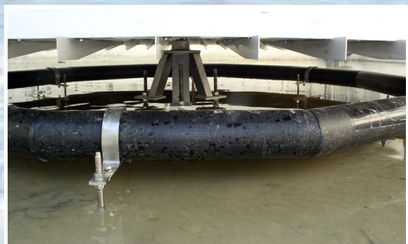
Detailansicht eines Rühr- und Begasungssystems
