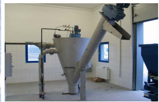
Sandwäscher mit Sandaustragschnecke
