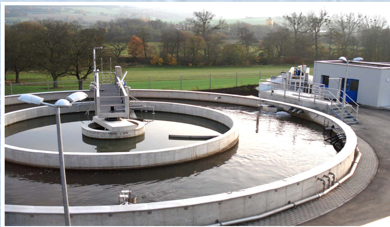
Ansicht der Kläranlage Gersheim mit Kombibecken im Vordergrund, Schlammverdicker und Schlamm pumpenhaus im Hintergrund
