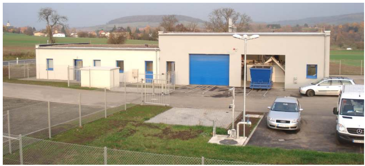
Betriebsgebäude der Kläranlage Gersheim mit Maschinenhalle (sichtbar: Sandcontainer) und Zentralspumpwerk im Vordergrund
