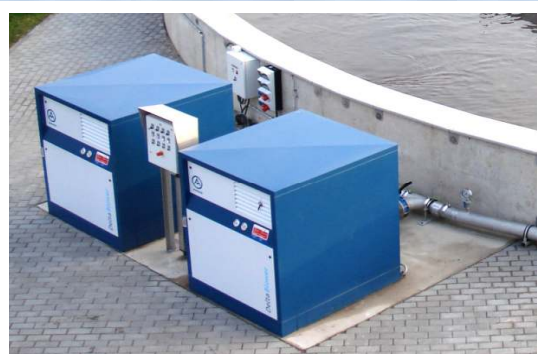
Drehkolbengebläse für die Sauerstoffzufuhr der Belebung
