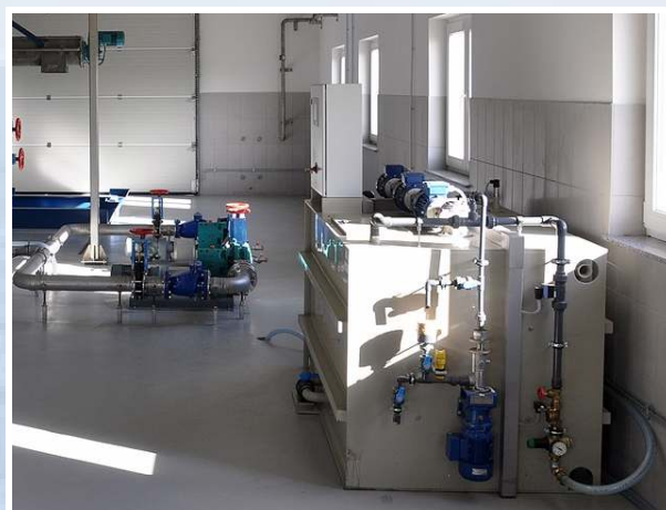
Automatische Polymerdosieranlage
