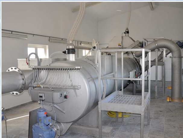
Das Herzstück der mechanischen Vorreinigung ist der Walzensandfang als Kompakteinheit mit integriertem Feinrechen, Rechengutwaschpresse und Fett- und Schwimmstoffabscheider.
