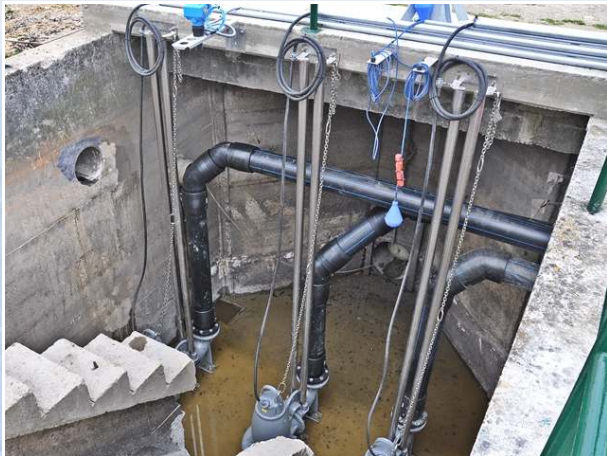
Das alte Schneckenpumpwerk wurde mit neuer Technik zu einer modernen Pumpstation umgebaut.
