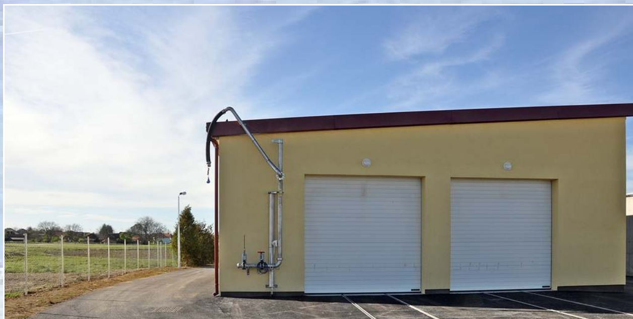
Flüssigschlamm-Entnahmegalgen außen am Schlammbehandlungsgebäude
