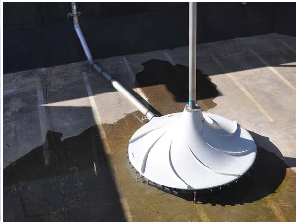
HyperClassic®-Rühr- und Begasungssystem mit ankommender Druckluftleitung
