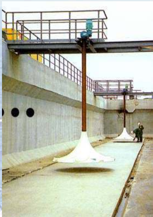
Slika br. 3: Dva HYPERCLASSIC® - sustava za miješanje u bazenu za denitrifikaciju. Jasno se uočava tipičan dizajn i jednostavnost instalacije.
