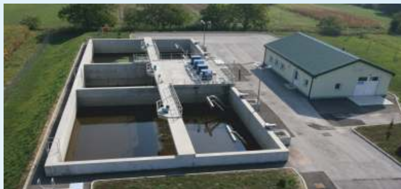
SBR-Kläranlage der Gemeinde Virje (Kroatien)
