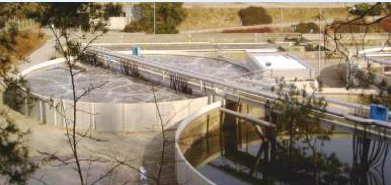
SBR-Kläranlage der Gemeinde Amreya (Ägypten)
