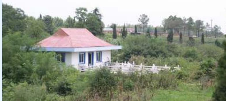
SBR-Kläranlage Gemeinde Sopo (China)
