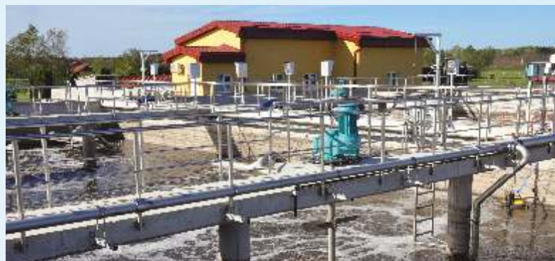
SBR-Kläranlage der Gemeinde Durdevac (Kroatien)
