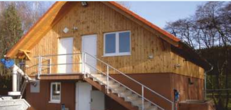
SBR-Kläranlage Gemeinde Hoxberg (Deutschland)
