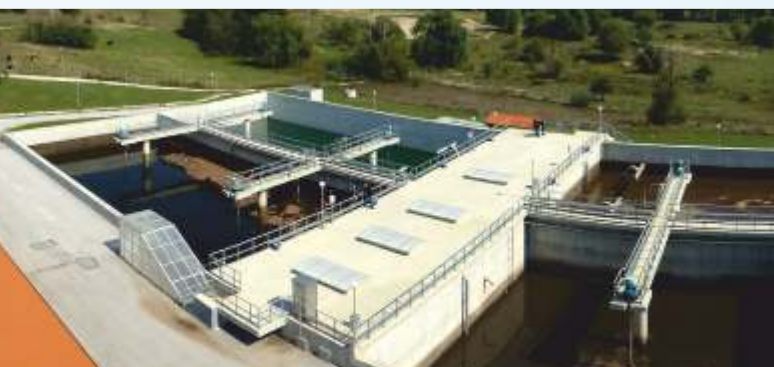
SBR-Kläranlage der Gemeinde Hisarya (Bulgarien)
