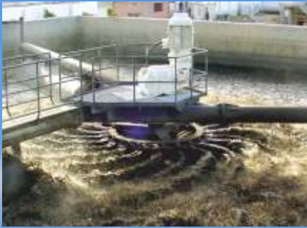
BSK®-Turbinen (Oberflächenbelüfter)
