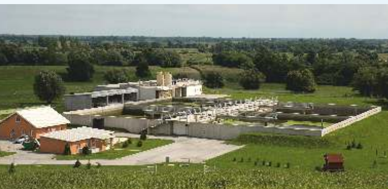
SBR-Kläranlage der Stadt Koprivnica (100.000 EW)
