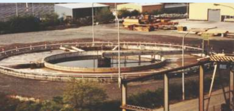
Kläranlage der Adam Opel AG (Deutschland)
