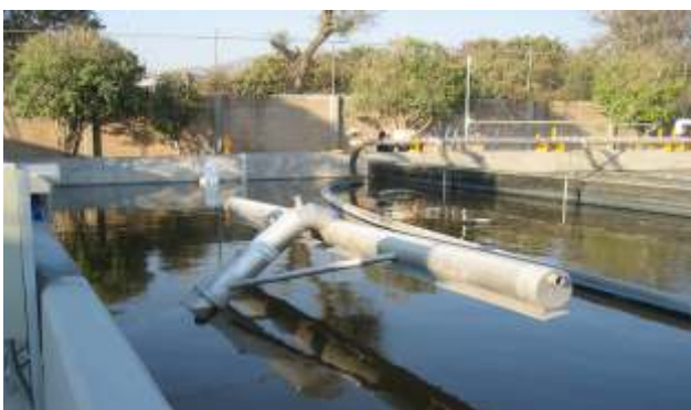
Trạm xử lý nước thải trong một nhà máy ở Mexico
