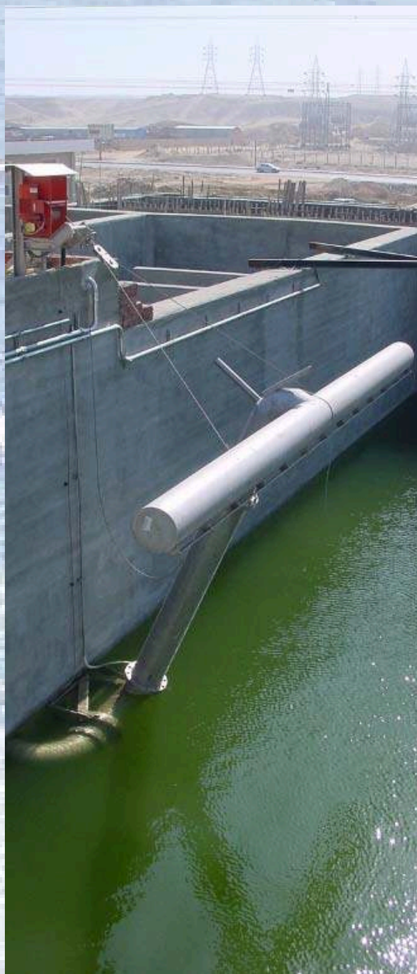
Декантер за извличане на пречистена вода, DN 350 на PCOB Амрея, Египет. Въртящата става и макаратата се виждат ясно на фотоса.
