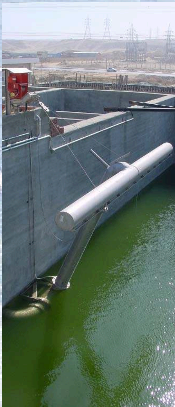
Dekanter za odvod bistre vode, DN 350, postrojenja Amreya u Egiptu. Jasno se vidi okretni zglob i užno vitlo.
