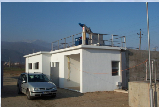
Kläranlage der SEE-Universität in Tetovo – 2.000 EW
