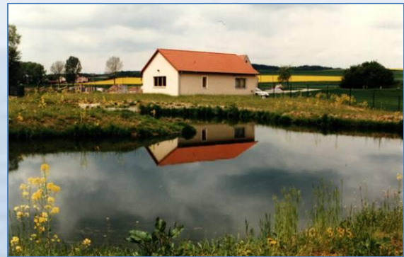
Kläranlage der bayerischen Stadt Schornweisach (2.000 EW)
