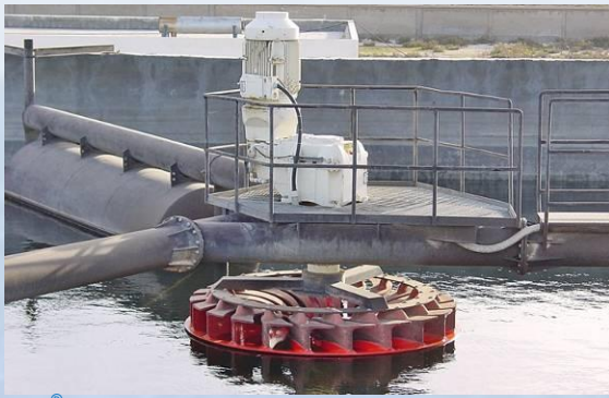
BSK®-Turbine für die SBR-Kläranlage der ägyptischen Stadt Amreya bei Kairo (50.000 EW)
