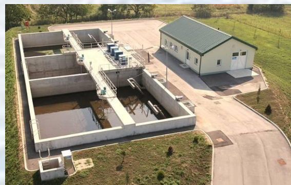
SBR-Kläranlage der kroatischen Gemeinde Virje (5.000 EW)
