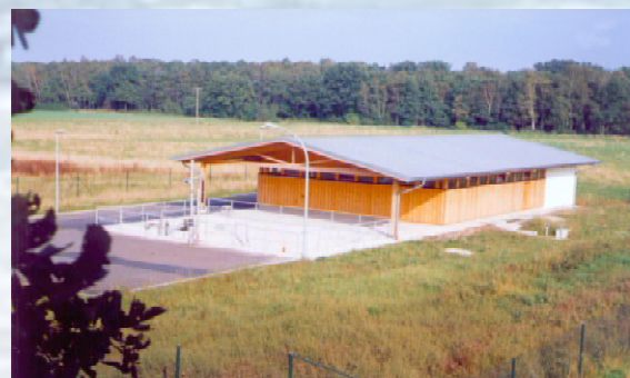
Kläranlage der Gemeinde Tettau (2.200 EW)
