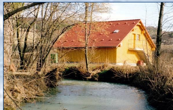
Kläranlage (SBR) der deutschen Gemeinde Göttern (600 EW)
