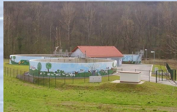
Kläranlage (SBR) der deutschen Gemeinde Großheringen (4.980 EW)
