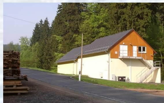
SBR-Kläranlage der sächsischen Gemeinde Hirschsprung (1.600 EW)
