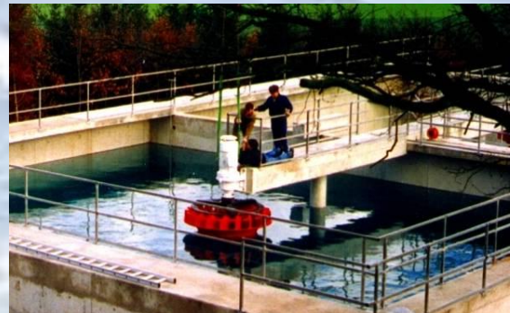
Kläranlage der Gerberei Bentrup (10.000 EW)
