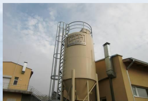
SBR-Kläranlage für die bulgarische Stadt Svilengrad (25.000 EW)
