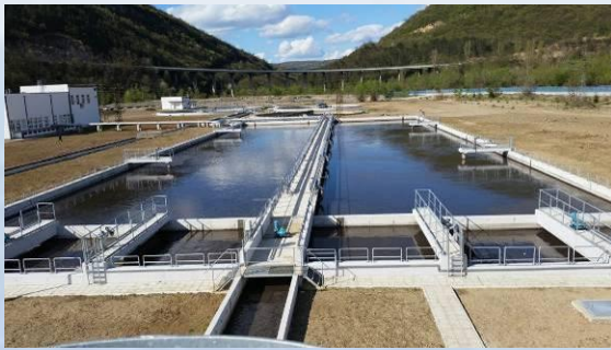
SBR-Kläranlage für die bulgarische Stadt Gabrovo (100.000 EW)
