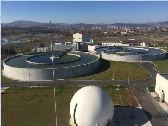
SBR-Kläranlage für die bulgarische Stadt Kardzhali (70.000 EW)
