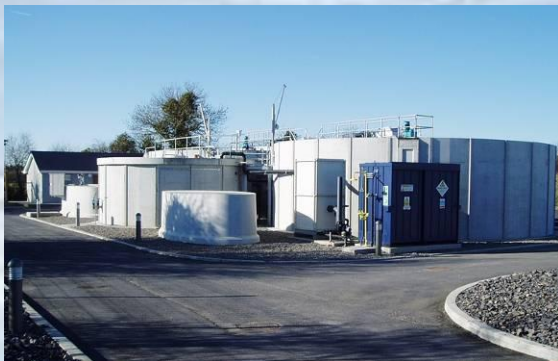
SBR-Kläranlage der irischen Gemeinde Derrinturn (2.400 EW)
