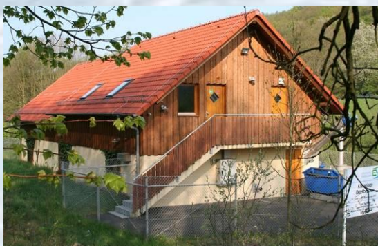
SBR-Kläranlage der deutschen Gemeinde Osterbrücken (750 EW)
