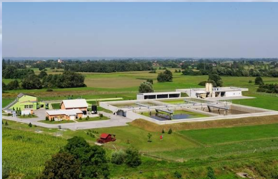
SBR-Kläranlage der kroatischen Stadt Koprivnica (100.000 EW)
