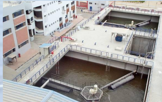
Kläranlage des CMC-Projektes bei Kairo
