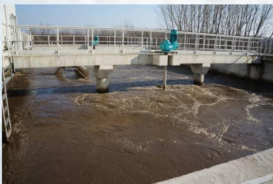
SBR-Kläranlage für die bulgarische Stadt Kozlodui (20.000 EW)
