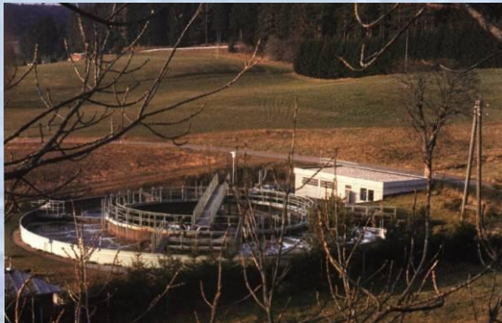
Kläranlage der Badischen Staatsbrauerei Rothaus AG (12.500 EW)
