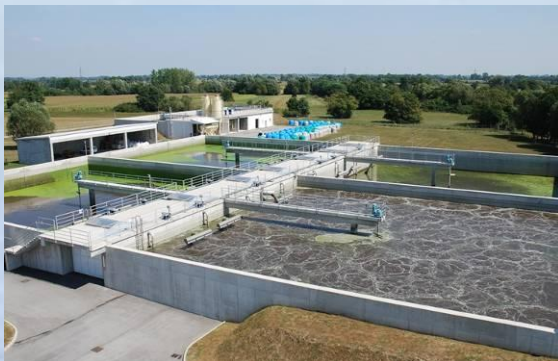
SBR-Kläranlage der kroatischen Stadt Koprivnica (100.000 EW)
