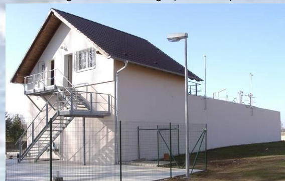
SBR-Kläranlage der sächsischen Gemeinde Ostrau (2.400 EW)
