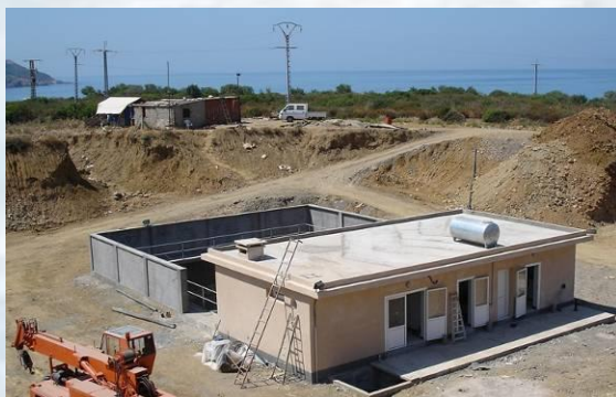
Biologische Kläranlage Sakiyet (1.000 EW)
