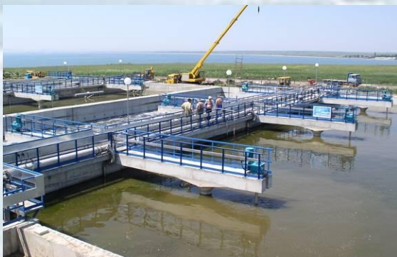
SBR-Kläranlage der bulgarischen Touristikzone "Sunny Beach" (65.000 EW)
