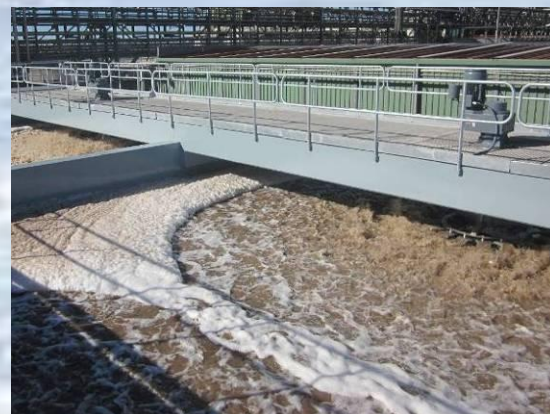
SBR-Kläranlage für eine Papierfabrik in Frankreich (30.000 EW)
