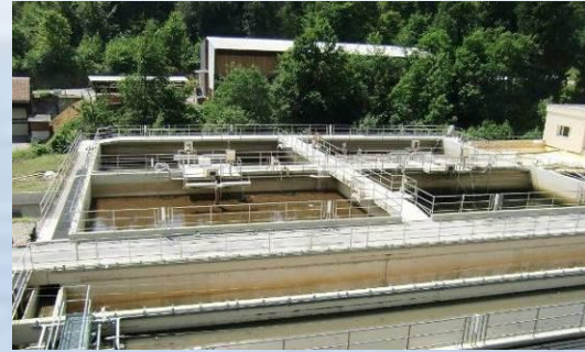
SBR-Kläranlage für die Schweizer Stadt Flims (35.000 EW)
