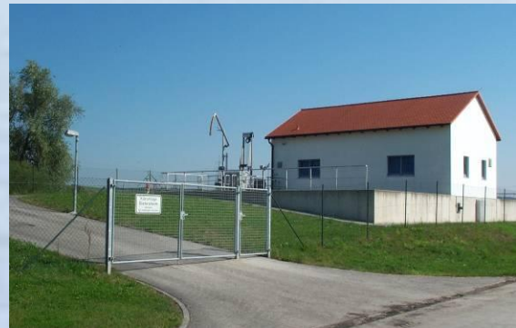
Kläranlage der deutschen Stadt Dietersheim (2.200 EW)
