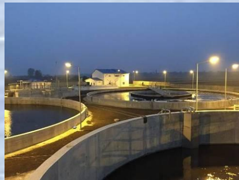
Kläranlage der rumänischen Gemeinde Liesti (30.000 EW)
