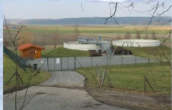
Kläranlage (SBR) der deutschen Gemeinde Großbothen (1.500 EW)
