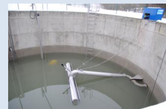
BSK®-Dekanter für die deutsche Kläranlage „Pfiffelbach“
